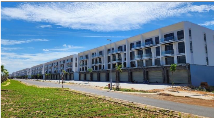
Hình 10: Dự án Sonadezi Hữu Phước
