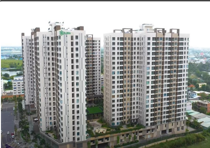
Hình 10: Dự án Akari City: 87% giai đoạn 1 đã được bàn giao từ cuối 2021. Giai đoạn 2 động thổ vào Q1/22, dự kiến bàn giao trong 2023
