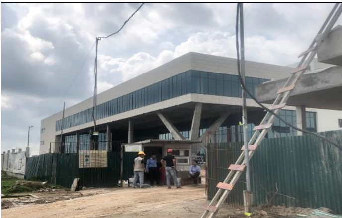
Hình 19: Dự án nhà kho đang xây dựng
