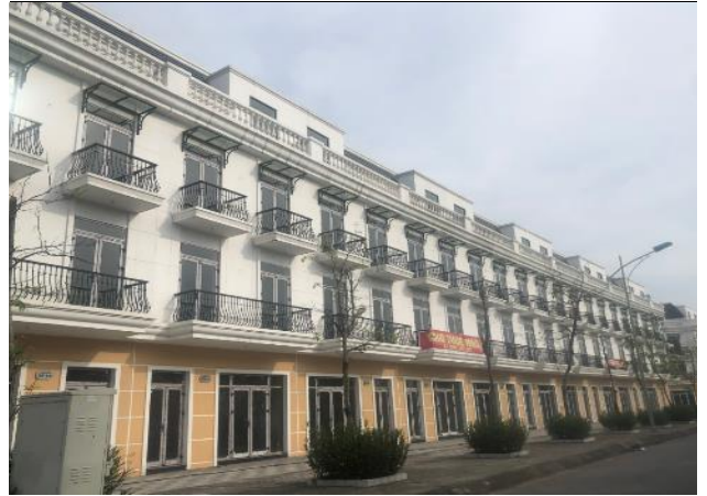
Hình 28: Hiện trạng shophouse đã hoàn thành xây dựng
