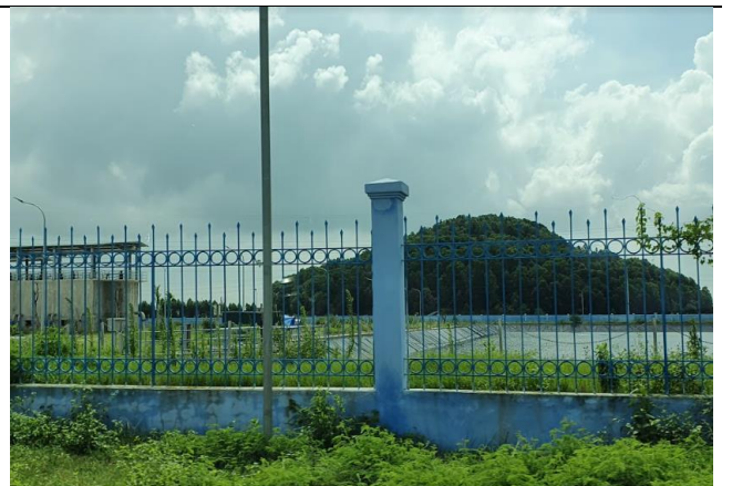
Hình 20: Nhà máy xử lý nước tại KCN Nam Sơn Hạp Lĩnh
