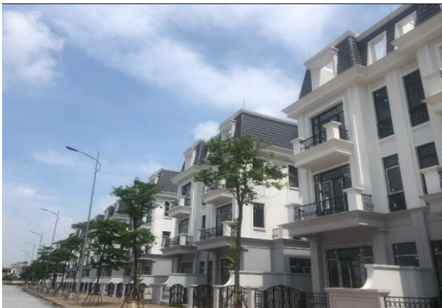
Hình 31: Hiện trạng các biệt thự đã hoàn thành xây dựng
