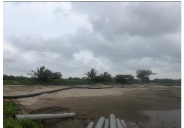
Hình 26: Các khu đang hoàn thiện san lấp tại KĐT Trảng Cát
