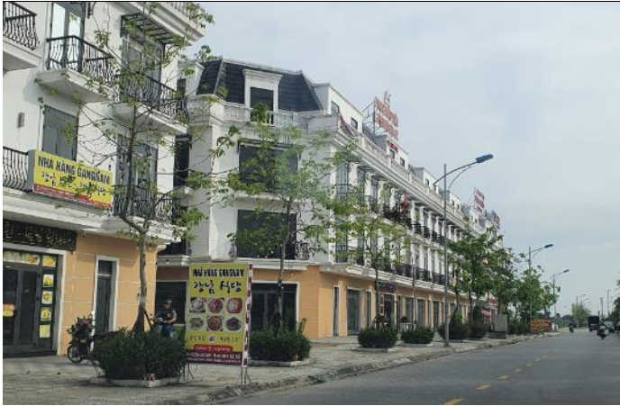
Hình 27: Hiện trạng shophouse đã hoàn thành xây dựng
