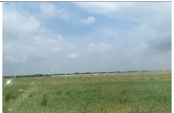
Hình 18: Phần diện tích đã hoàn thành san lấp
