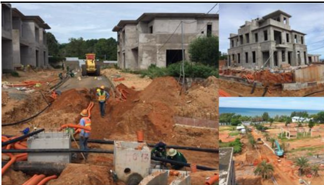
Hình 11: Dự án Casa Marina Mũi Né
